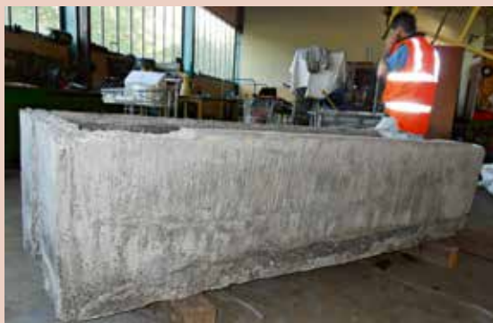
Réfection des deux fontaines du Kattenbach
