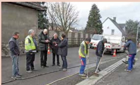
Travaux de voirie rue Saint Martin
