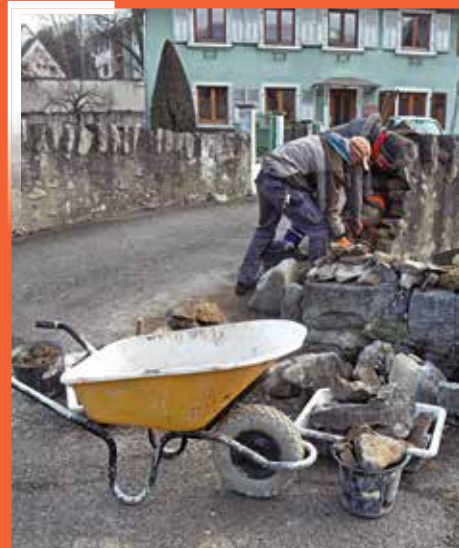
Réparation à l'identique du pont du Kattenbach
