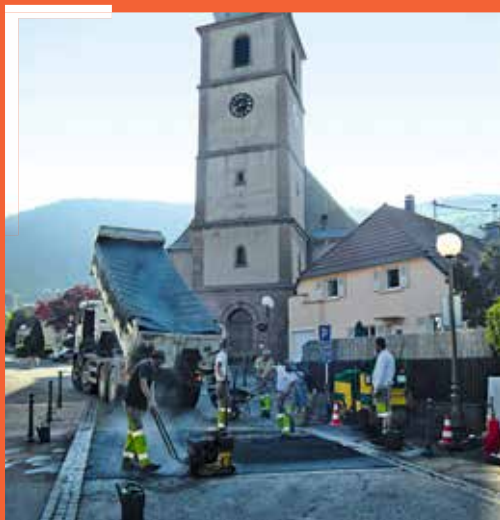
Réfection d'enrobés place Foch
