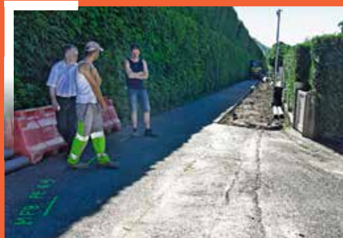
Traux de récupération des eaux de pluie rue Maréchal Joffre
