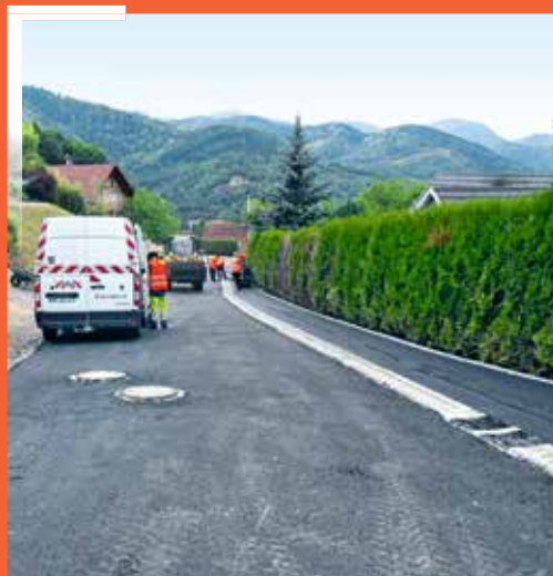
Remise en état rue du Panorama
