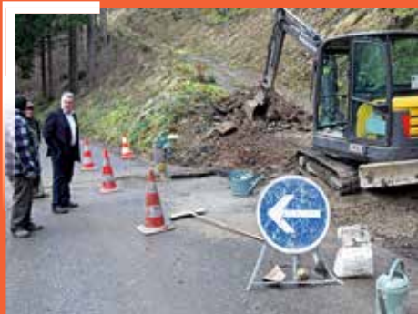
Drainage des eaux de pluie sur la route de Geishouse
