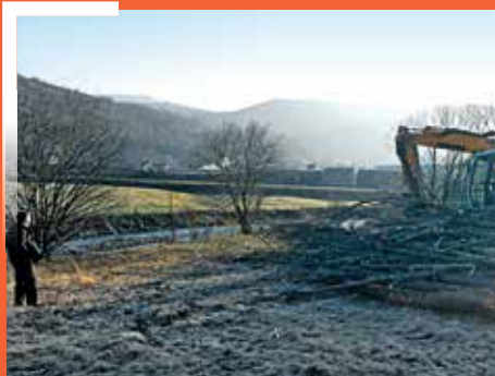
Travaux d'élagage le long de la Thur
