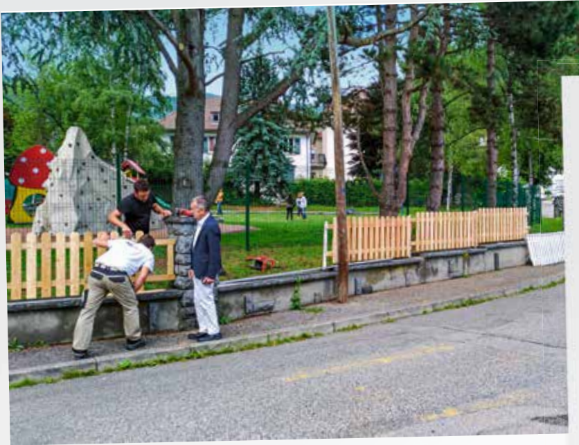
Réfection clôture Parc à jeux CAP
