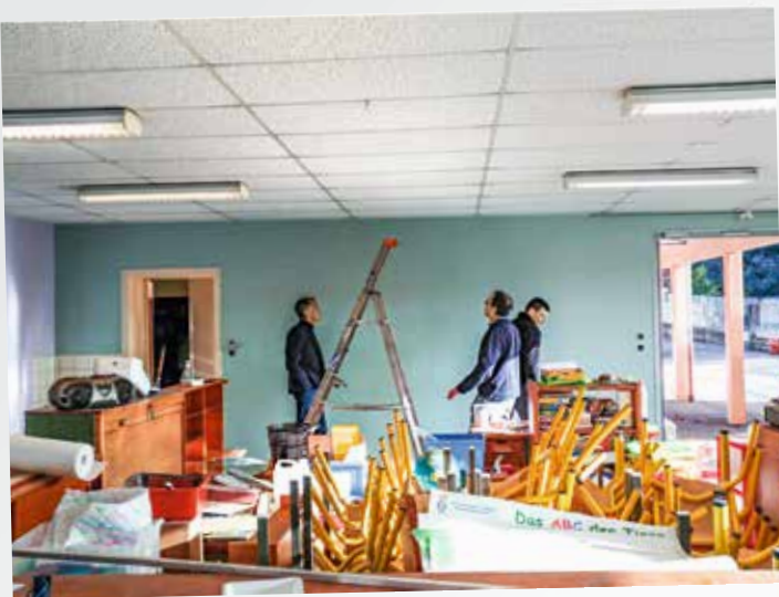
Réfection salle de classe Ecole maternelle
