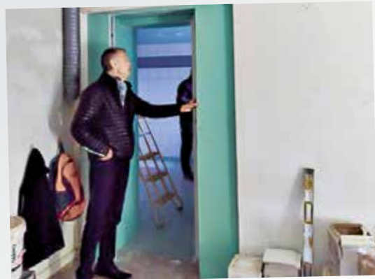
Réfection appartement poste
