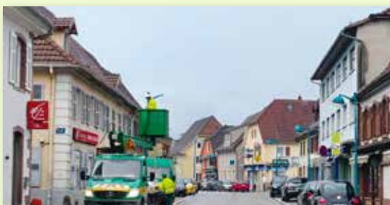
Economie d'énergie : remplacement des points lumineux par des éclairages leds
