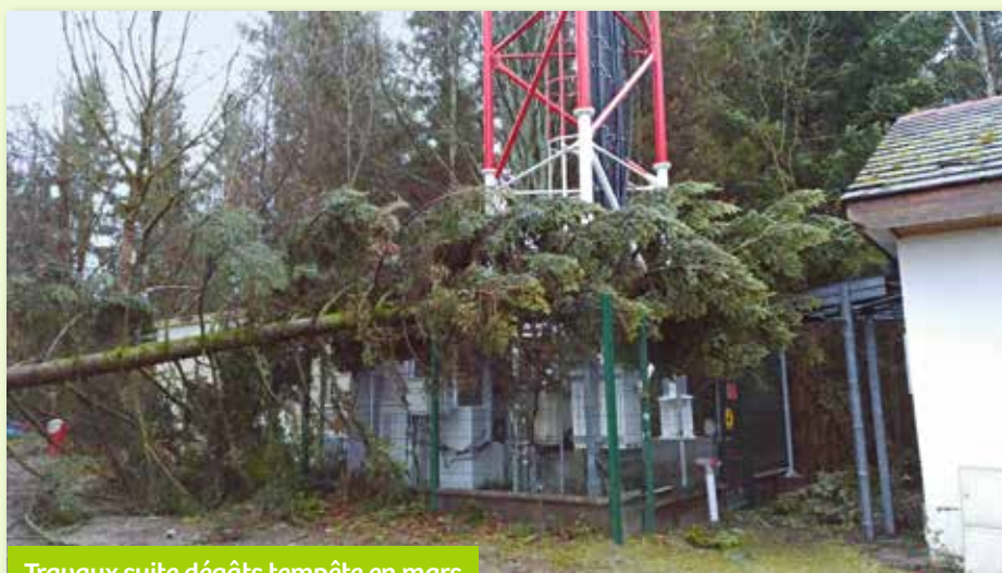
Travaux suite dégâts tempête en mars
