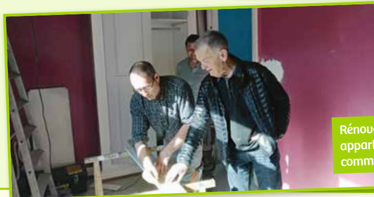
Rénovation fontaine Mairie
