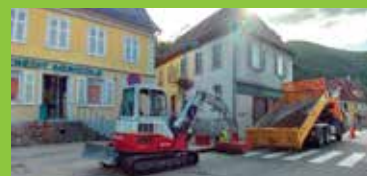
Poursuite des travaux des réseaux de fibre optique
