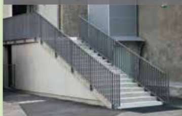
Nouvel accès avec ascenseur
