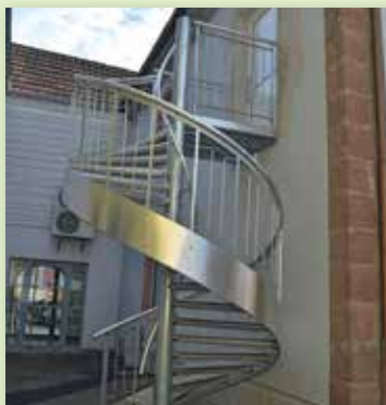
Nouvel escalier de secours
