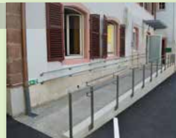
Nouvelle rampe d'accès
