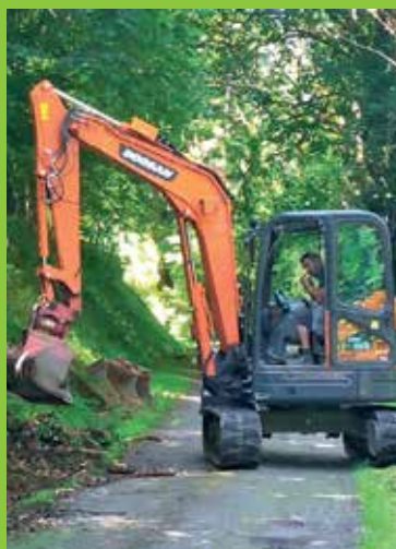
Ouverture des fossés
