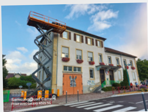
Remplacement des gouttières
