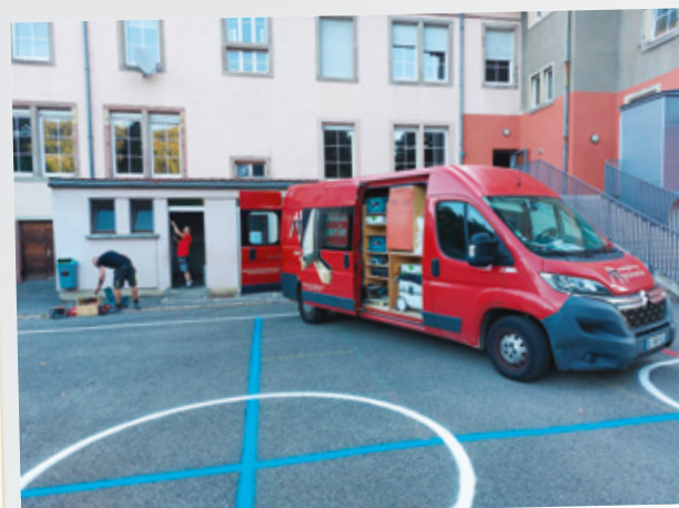
Remplacement des portes des sanitaires
