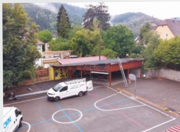
Finalisation travaux préau
