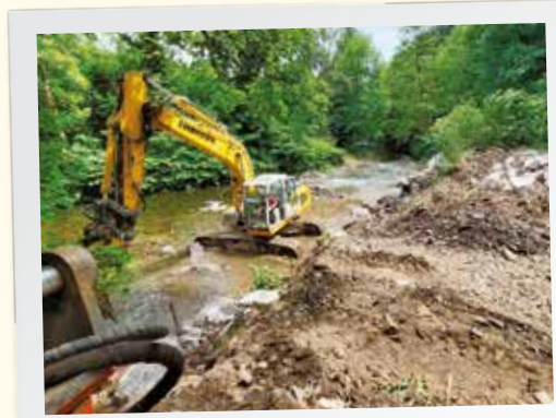
Des travaux d'enrochement ont été réalisés dans la Thur
