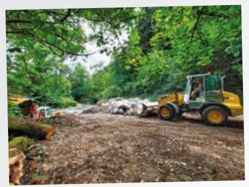
Des travaux d'enrochement ont été réalisés dans la Thur
