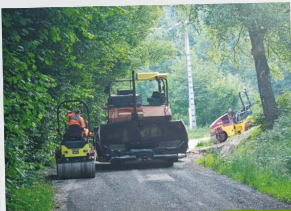
Au terme des travaux de remplacement, le tapis de roulement a trouvé une nouvelle jeunesse.
