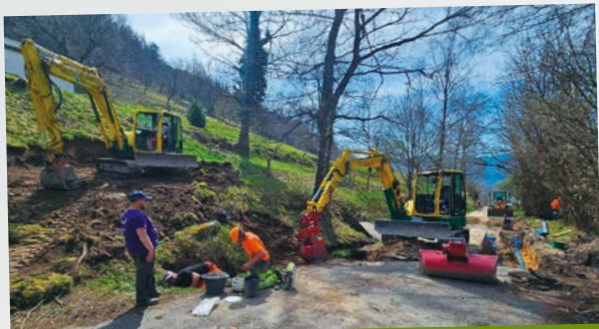
Sous la conduite de la Communauté de Communes, d'importants travaux ont été réalisés sur le quartier du Fistelhaeuser. Plusieurs conduites d'eau potable ont été remplacées.
