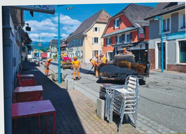
La CEA a entrepris des travaux d'entretien de la rue Charles de Gaulle.
